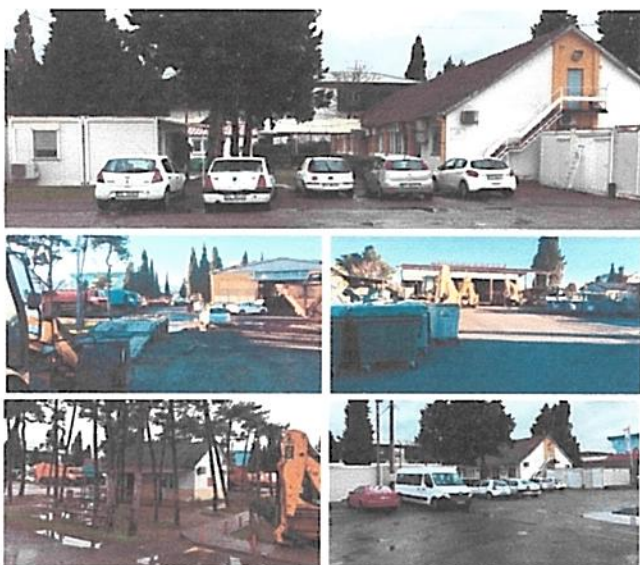
Slika 1. Postojeće stanje upravne zgrade sa pratećim objektima
