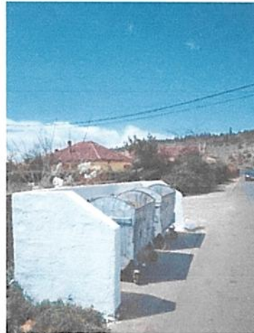
Izgradnja i uklanjanje grafita sa niša
