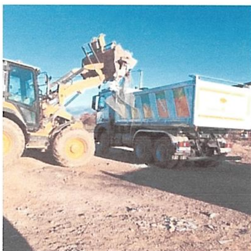
Sanacija neuređenih odlagališta
